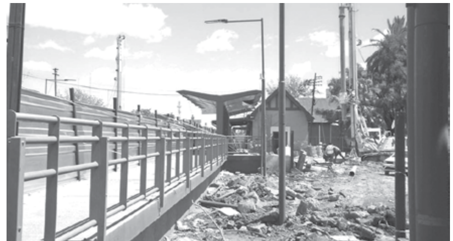
Obras en la estación La Paternal.
